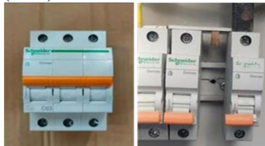
Gambar 2 MCB 3 Phase dan MCB 1 Phase
