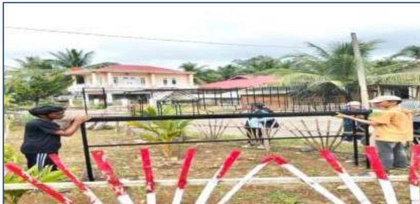
Gambar 3. Proses pemasangan Kerangka Besi
