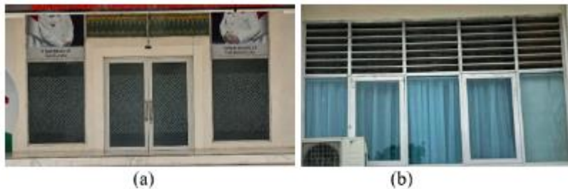
Gambar 4. Bagian (a) Bukaannya Pintu dan Bagian (b) Bukaannya Jendela (Dokumentais Penulis, 2026)
