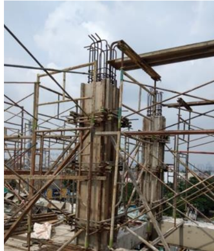
Gambar 4 Pemasangan Bekisting Kolom Sumber: Dokumentasi Lapangan.
