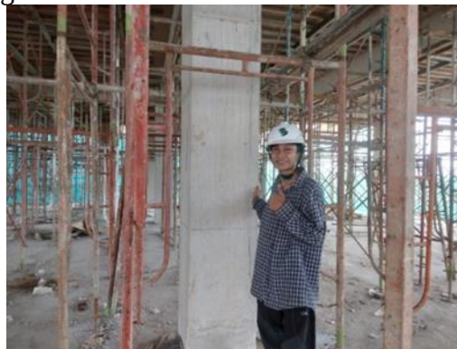
Gambar 6 Pembongkaran Bekisting Kolom
