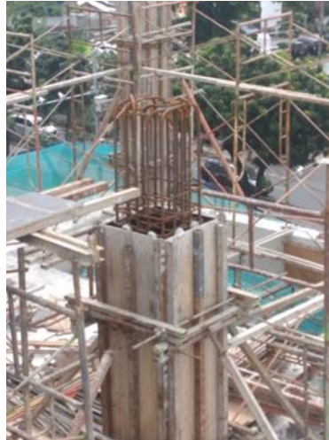
Gambar 6 Pelaksanaan Pengecoran Sumber: Dokumentasi Lapangan.
