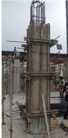
Gambar 5 persiapan pengecoran Sumber: Dokumentasi Lapangan
