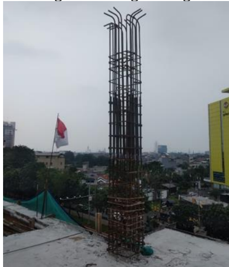
Gambar 3 Pembesian Kolom Sumber: Dokumentasi Lapangan.
