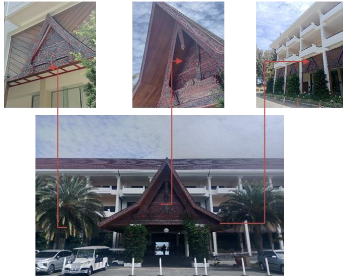
Gambar 5 Gambar Komponen Atap Sumber: Penulis, 2025
