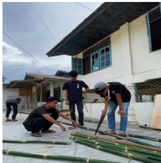
Gambar 4. Proses pengukuran dan perakitan komponen struktur gapura
