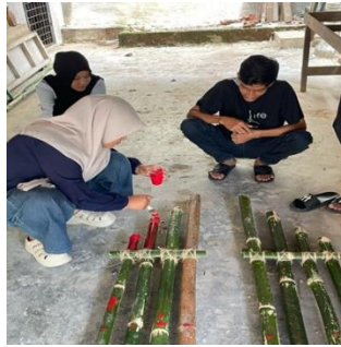
Gambar 5. Proses finishing dan pengecatan komponen gapura
