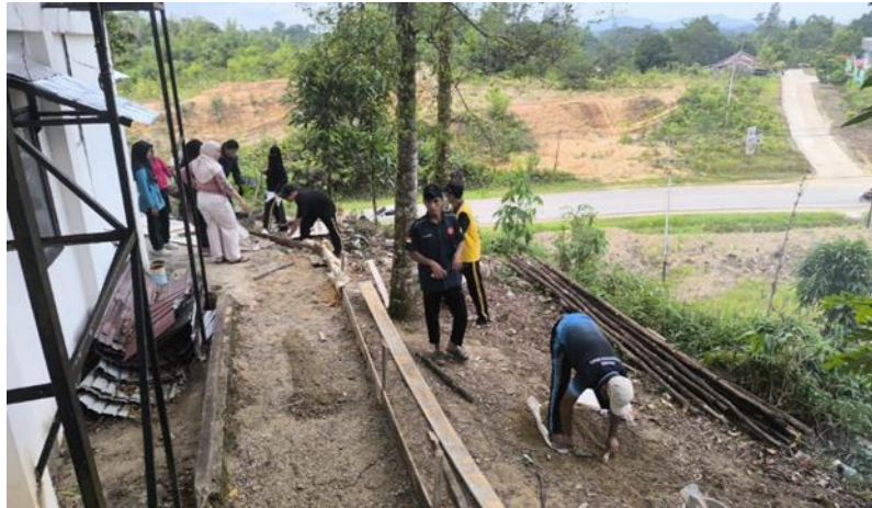
Kegiatan pengecoran jalan Gambar .6 ( Pengecoran jalan kampus )
