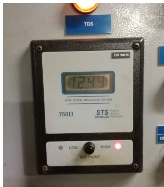
Gambar: 11. Kadar larutan padat yang tinggi
