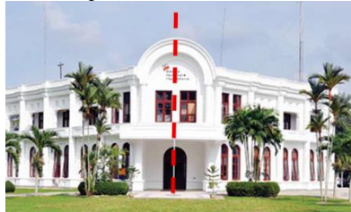
Gambar 12. Fasad simetris pada bangunan PT BSP Kota Kisaran (Sumber, Analisa peribadi)
