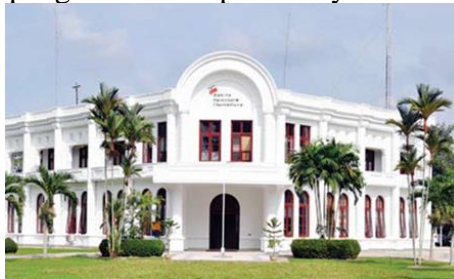
Gambar 16. Warna bangunan pada PT BSP Kota Kisaran (Sumber, Analisa peribadi)
