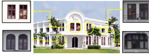
Gambar 14. Jendela pada PT BSP Kota Kisaran (Sumber, Analisa peribadi)
