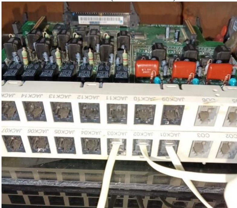
Gambar 55 Pemasangan kabel RJ-11 ke slot JACK 02/03 (Client Telepon)
