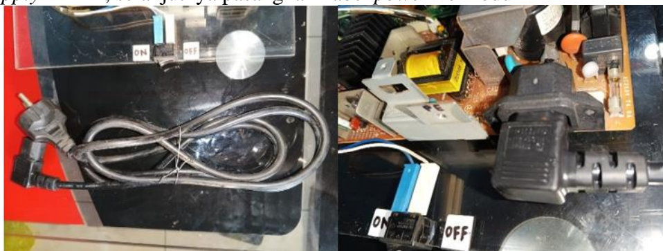
Gambar 22 Pemasangan Kabel Power Sumber: Dokumentasi Penulis, 2024
