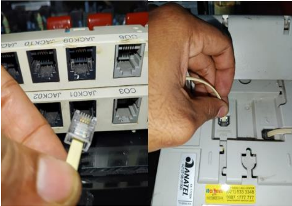
Gambar 54 Pemasangan kabel RJ-11 ke slot JACK 01(Master Telepon)
