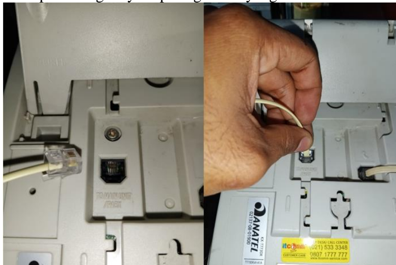
Gambar 24 Pemasangan Kabel RJ-11 ke Master telepon Sumber: Dokumentasi Penulis, 2024
