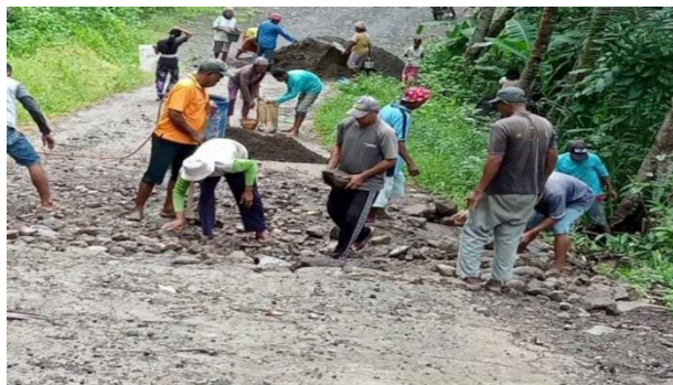
Gambar 1. Perbaikan Jalan Umum di Desa Lusi Duawutun
